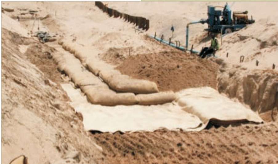
Photo 3: Double layer EnviroRock™ Wall
