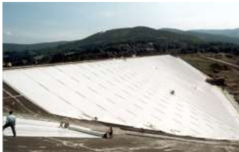
(a) Earth fill dam
